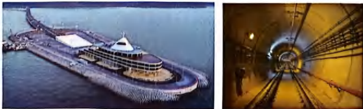
图4-14 港珠澳大桥海底隧道出入口、地铁隧道
