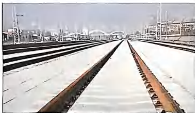
图4-26 混凝土宽枕
