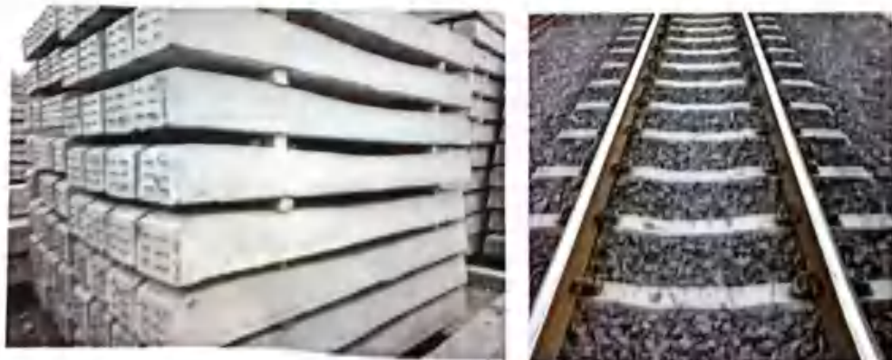
图4-25 混凝土轨枕
